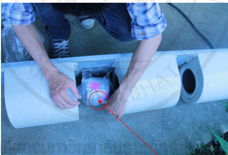
ภาพประกอบ 20 แสดงการใช้ถุงพลาสติกห่อหุ้มชุดมอเตอร์คอลย์เย็นก่อนล้างทำความสะอาด
