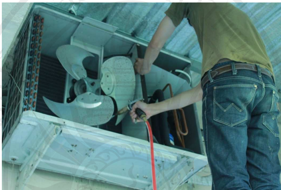
ภาพประกอบ 25 แสดงการฉีดล้างทำความสะอาดชุดคอยล์ร้อนของเครื่องปรับอากาศ
