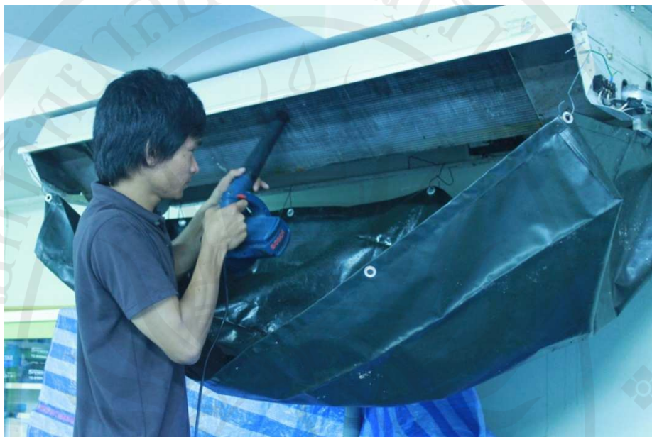
ภาพประกอบ 19 แสดงการใช้เครื่องเป่าลมไฟฟ้าเป่าล้างทำความสะอาดแผงคอลย์เย็น
