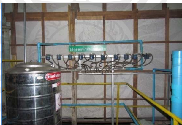
ภาพประกอบ 37 ระบบกรองผ่านไส้กรอง ก่อนนำไปใช้งาน
