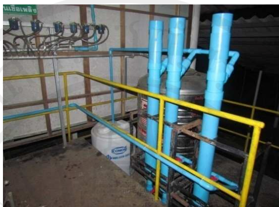
ภาพประกอบ 36 ระบบกรองเกลือแยกน้ำและความชื้นชุดที่ 2 หลังจากกรองแยกไขไบโอดีเซล
