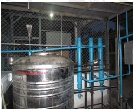
ภาพประกอบ 32 ระบบกรองเกลือตกแยกน้ำและสิ่งปนเปื้อน ภายในบรรจุตะแกรงกรองละเอียด
