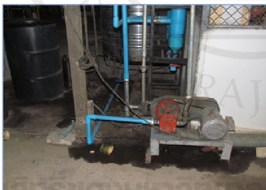
ภาพประกอบ 35 ระบบปั๊มส่งน้ำมันสู่ระบบกรองดักแยกไขไบโอดีเซล และระบบกรองดักแยก ฯ
